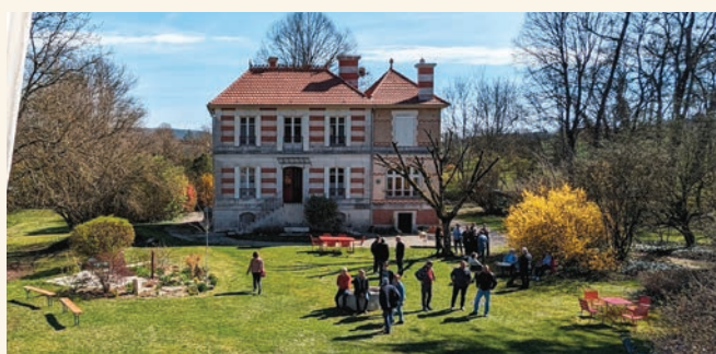
Des travaux pour davantage d'élégance à Vanvey.
